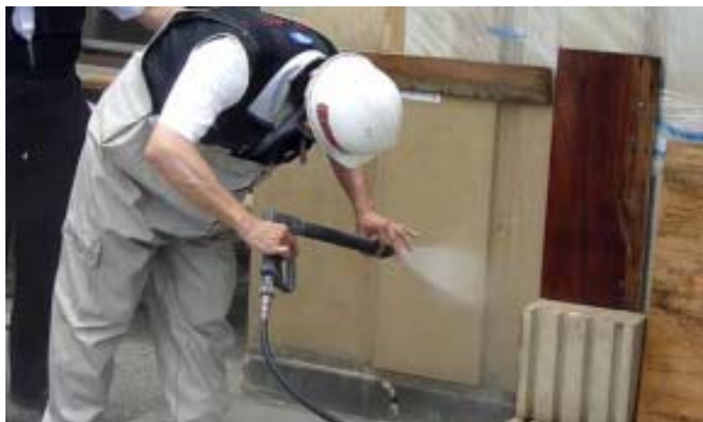
サイクロンジェットによる洗浄・一次コーティングの状況
