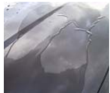
施工後のウォーターコート
