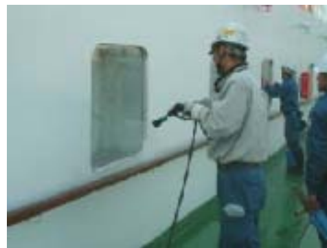
大型フェリーガラス窓の施工
